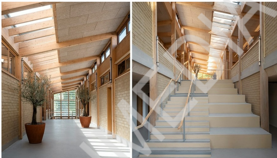
Résolument durable, le bâtiment dispose d'une structure en bois, de briques de terre crue en intérieur et d'isolants biosourcés en fibres de bois. (Tolila+Gilliland)
